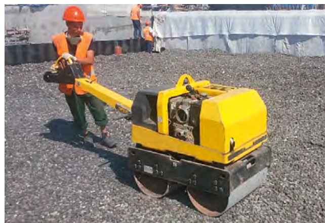
Рис. 8. Пример выполнения работ с использованием виброкатка
