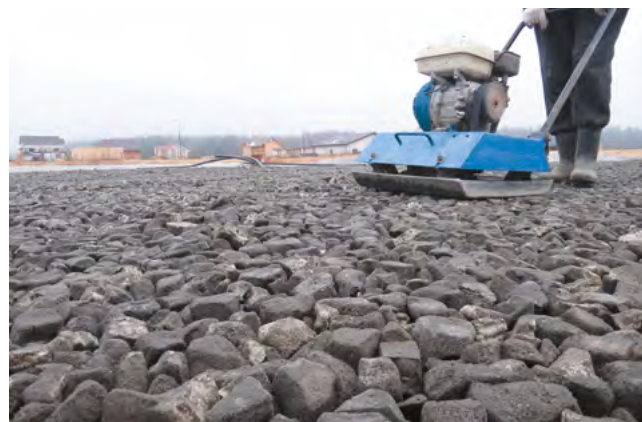
Рис. 8. Пример выполнения работ с использованием виброкатка
