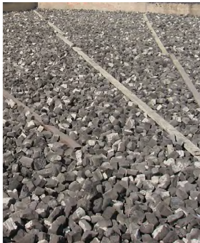
Рис. 2. Построение плоскостей при помощи металлических направляющих
